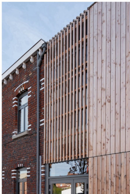
— Le projet fait la part belle à l'emploi du bois, de la structure au bardage et de la sur-toiture jusqu'aux parements intérieurs.
