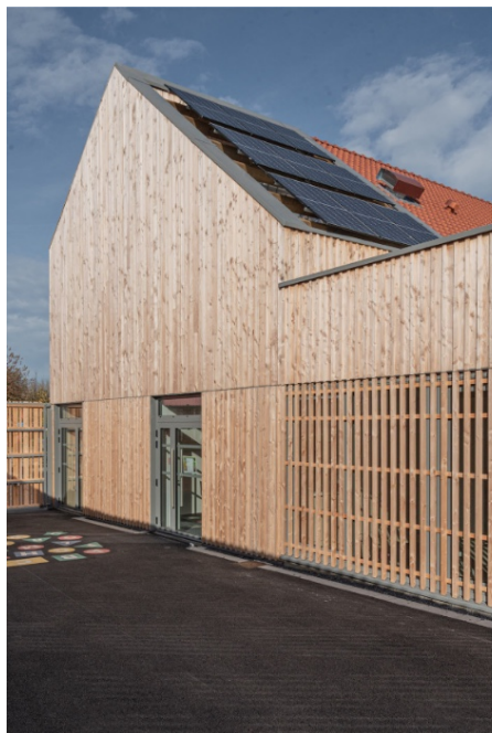
— Le projet fait la part belle à l'emploi du bois, de la structure au bardage et de la sur-toiture jusqu'aux parements intérieurs.
