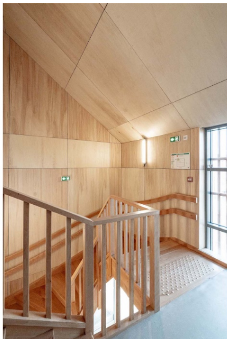
— Le projet fait la part belle à l'emploi du bois, de la structure au bardage et de la sur-toiture jusqu'aux parements intérieurs.
