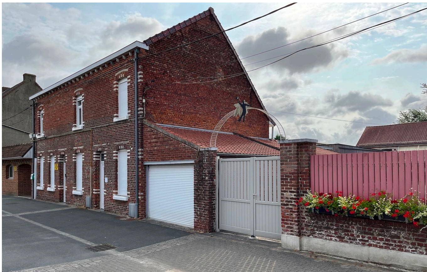
— Etat existant des bâtiments communaux
