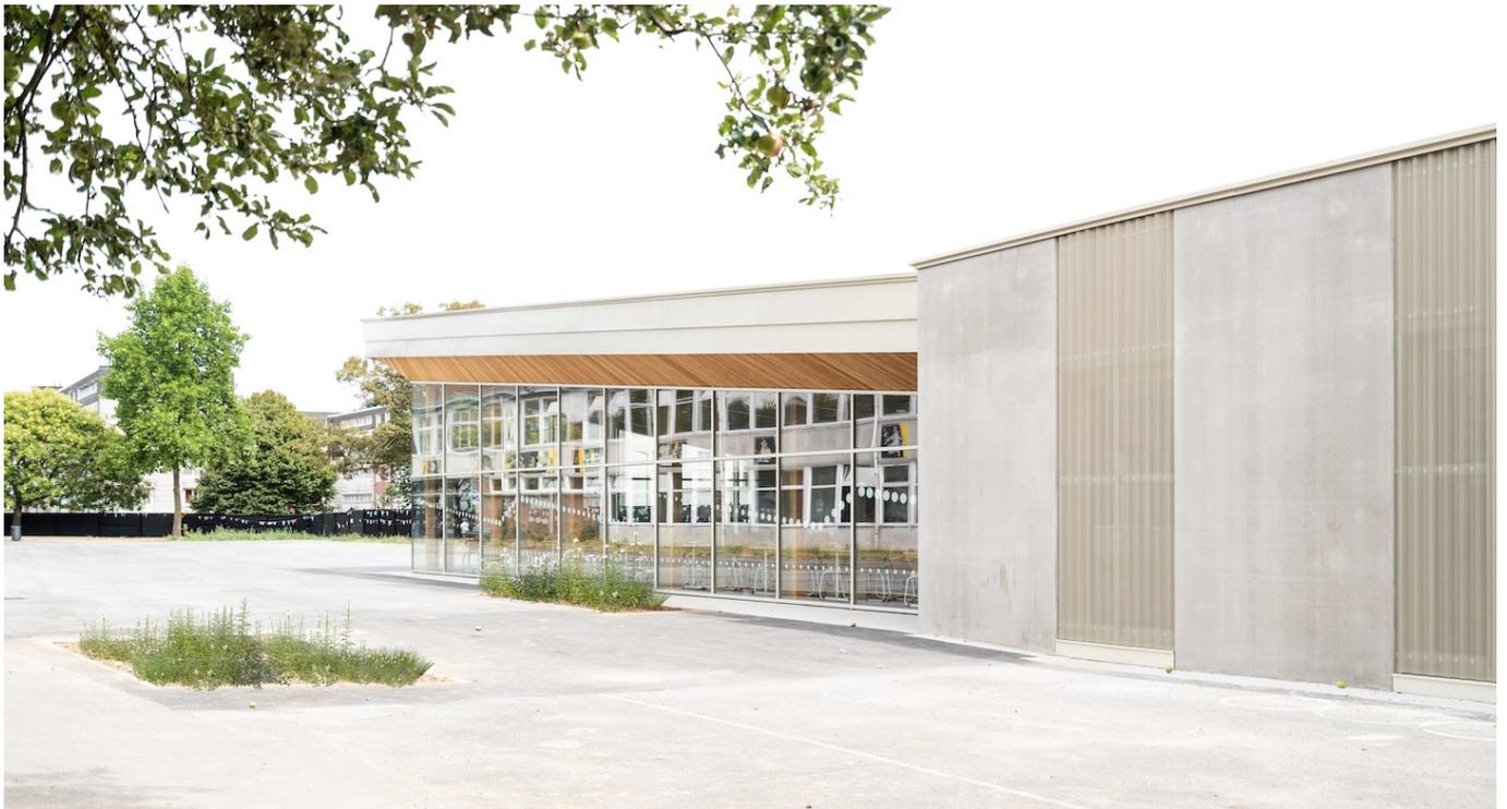
— Le bardage métallique permet d'intégrer les ouvertures dans les parois béton
