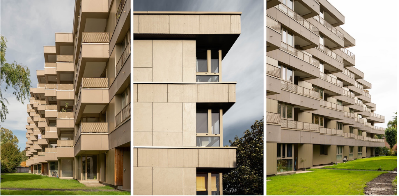
— La résidence Beaupré après réhabilitation
