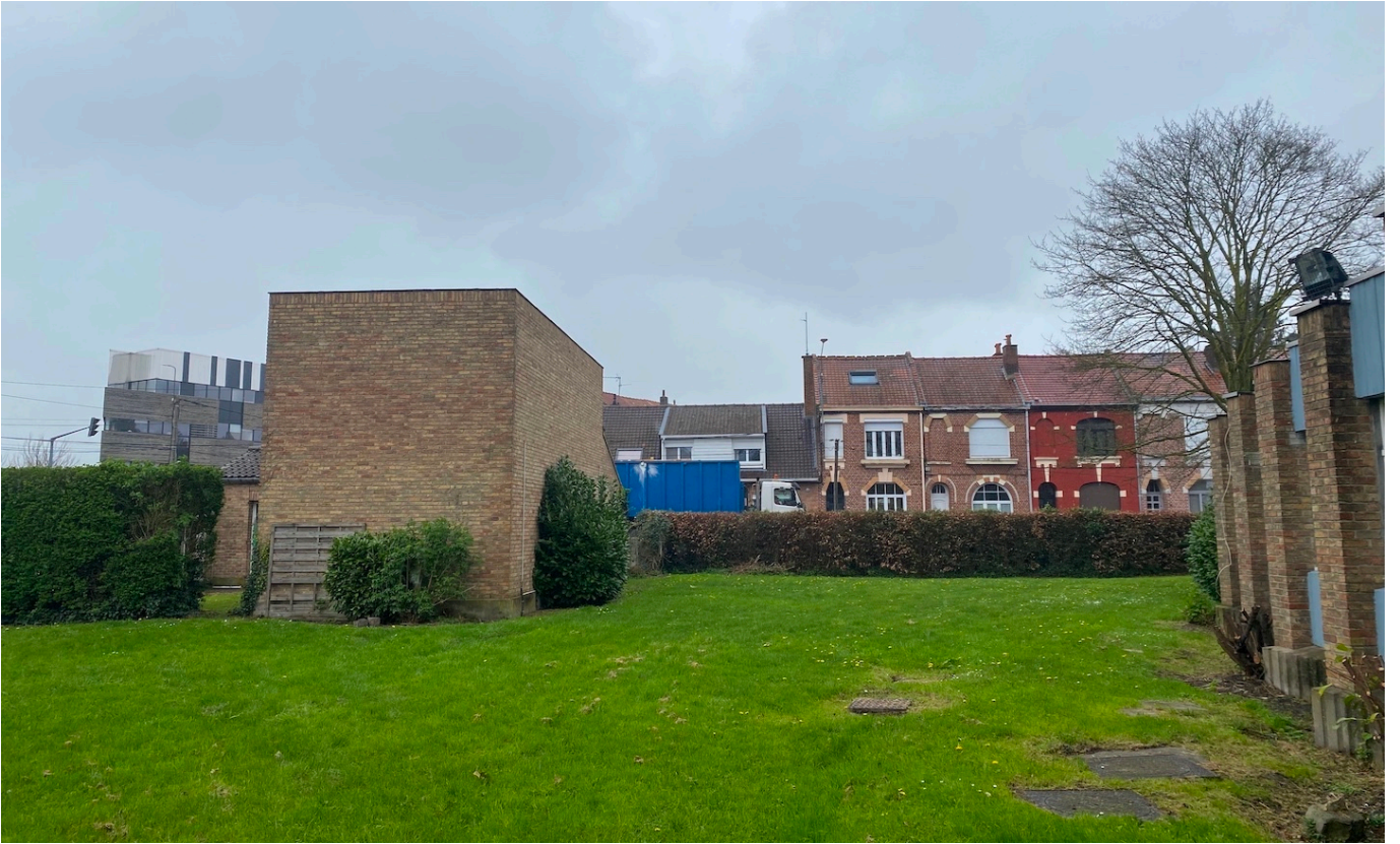
— La future extension viendra s'accoler au bâtiment existant
