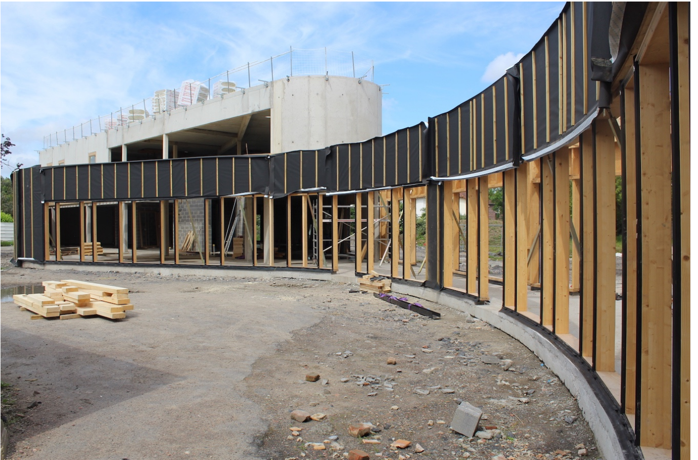
— Chantier en cours
