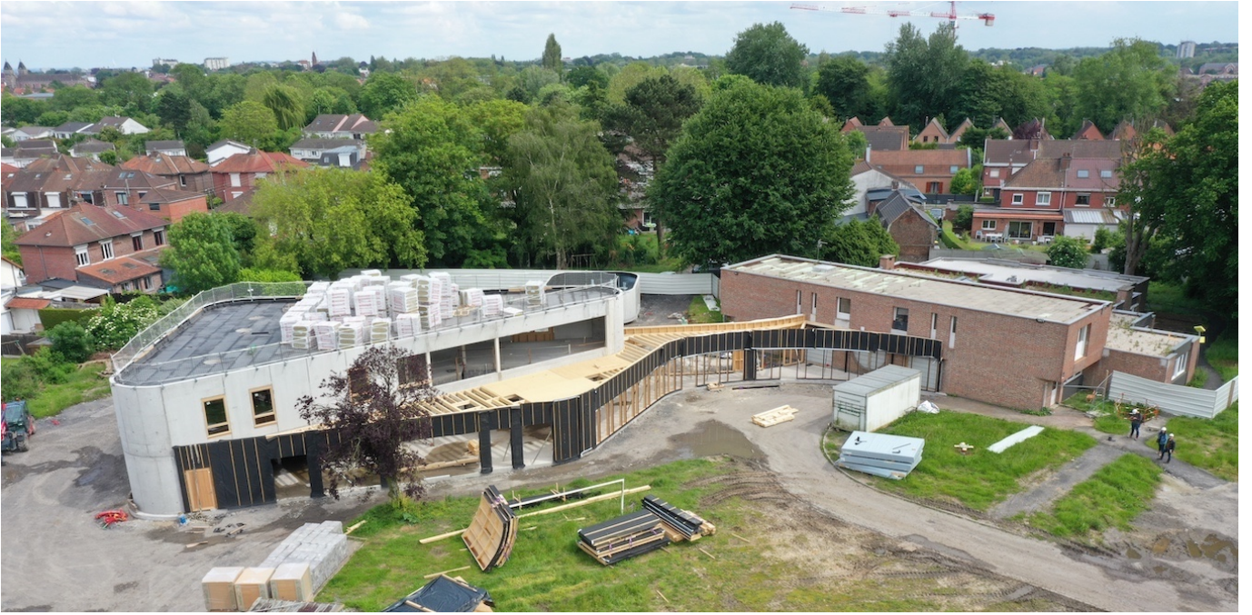
— Chantier en cours
