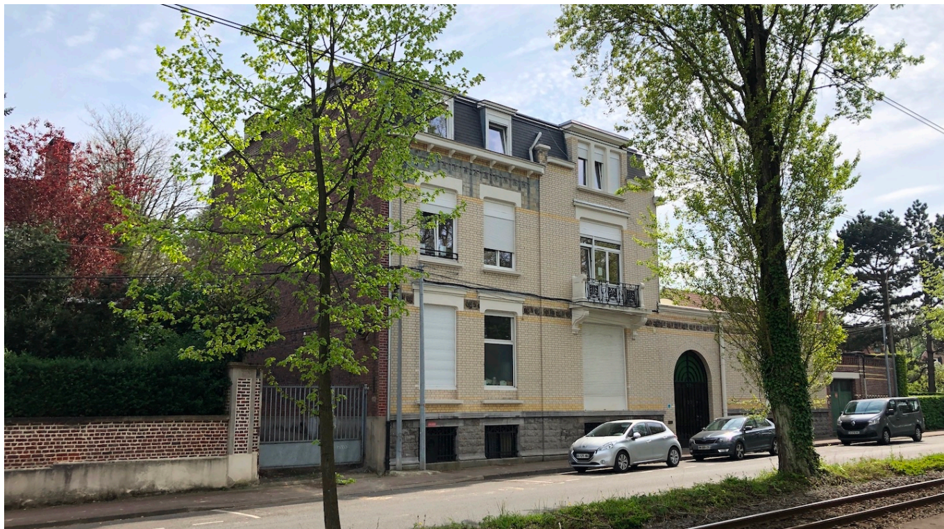
— Vue existante de la maison d'enfants depuis le boulevard Carnot
