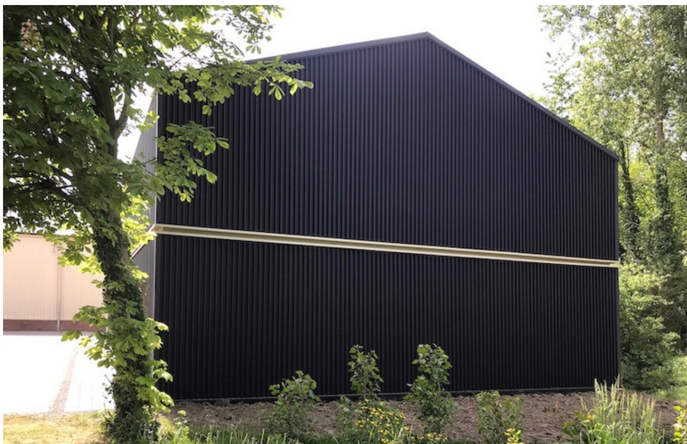
— Détail du bardage métallique sur le pignon Nord de la halle
