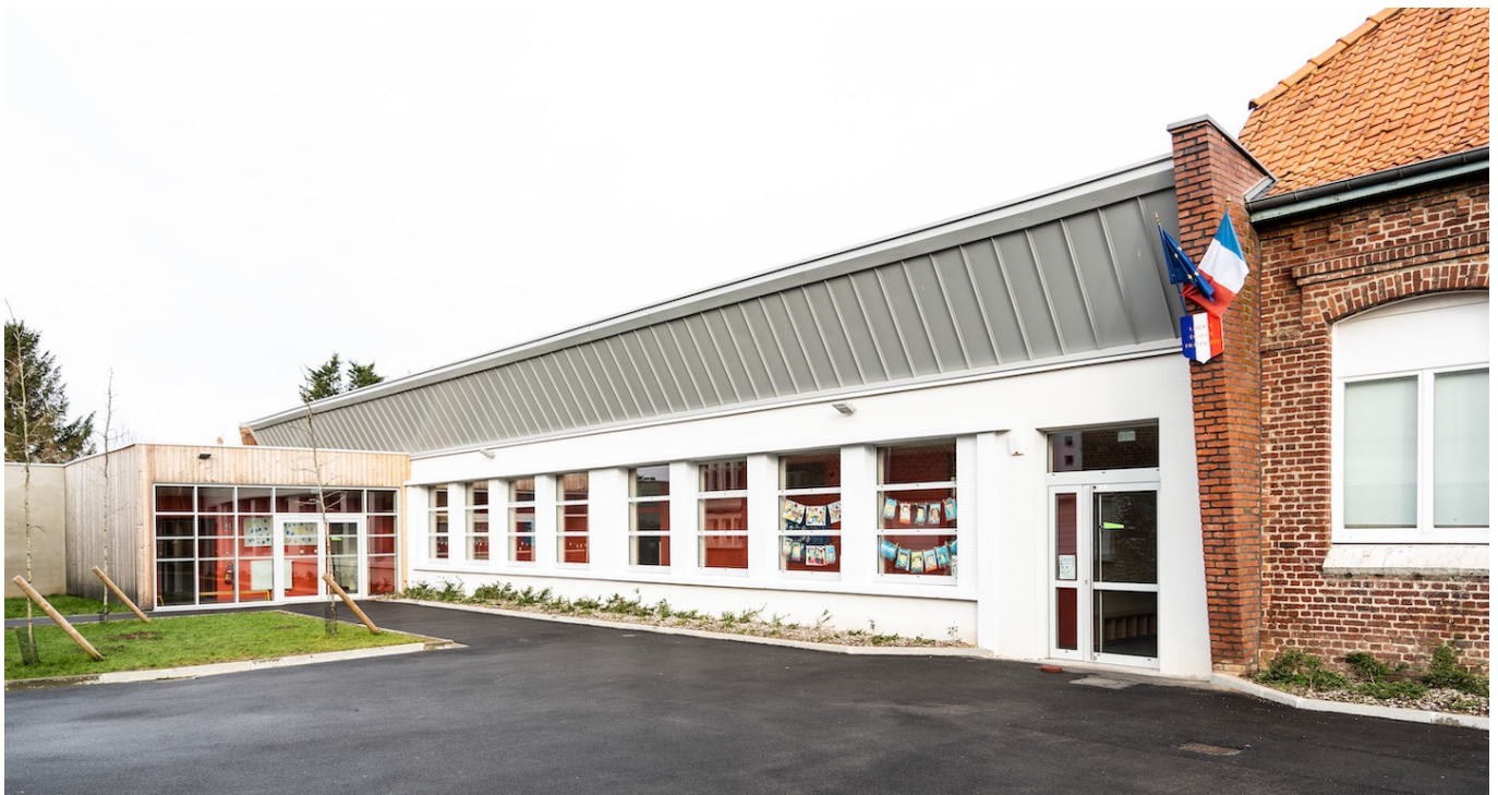
— Vue sur l'école et son extension
