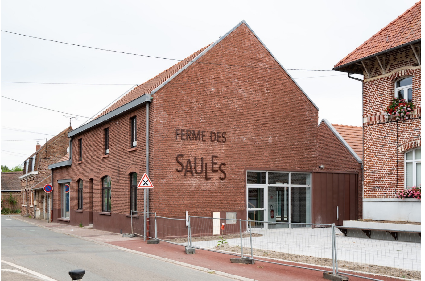
— Traitement du pignon
