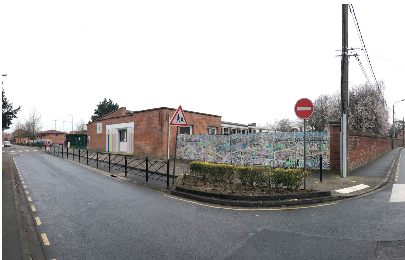
— Vue sur l'état actuel de l'école depuis la rue de l'Aggripin
