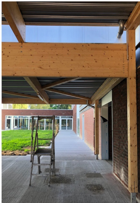
— Chantier en cours
