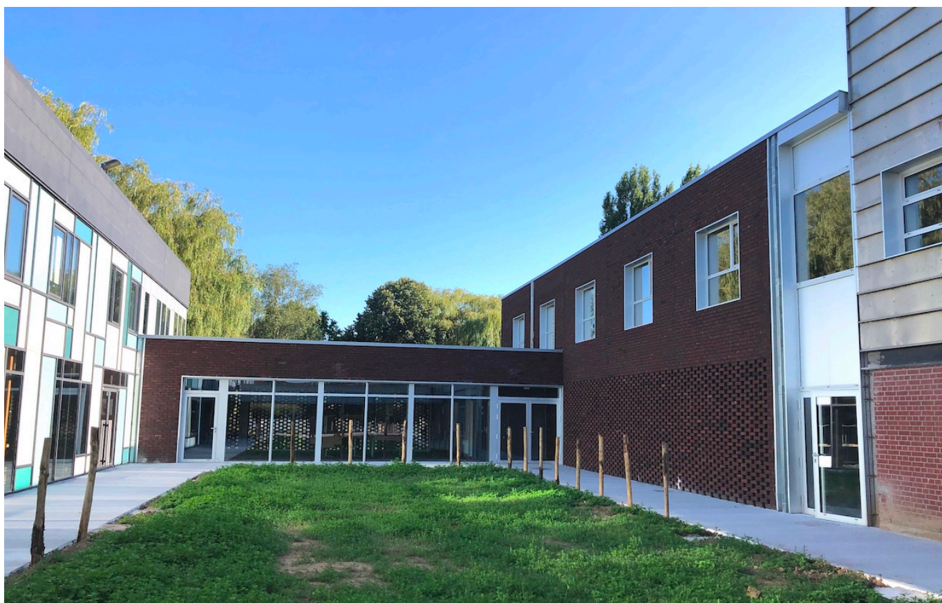
— Chantier en cours
